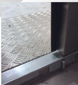
Rampe d'accès à l'entrée pour un passage plus facile des matériels lourds.
