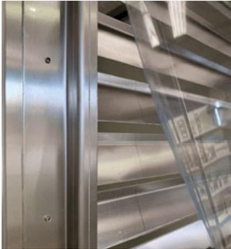
Portes en aluminium et grilles intégrées dans l'épaisseur, système flap aimanté.
