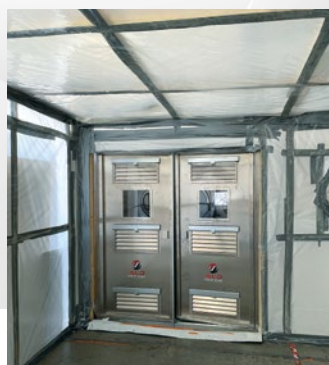
Parfaitement intégrable dans les chantiers de décontamination et désamiantage.
